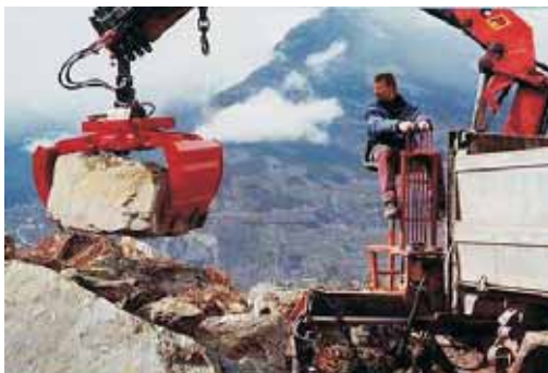
Utilisation grappin à pierres-avec cotés ouverts
